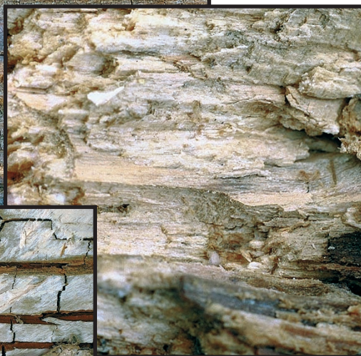
„Svampeskade“ med trævlet, lyst ved (hvidmuld), men uden overflademycelium.
